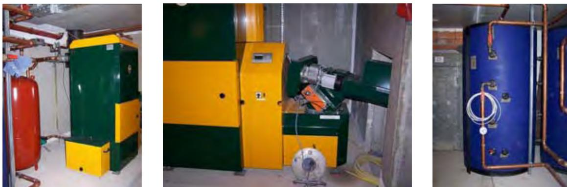
**Bild 264** Einbausituation Holzpelletkessel und Pufferspeicherkaskade Heizzentrale Brentanostr.
