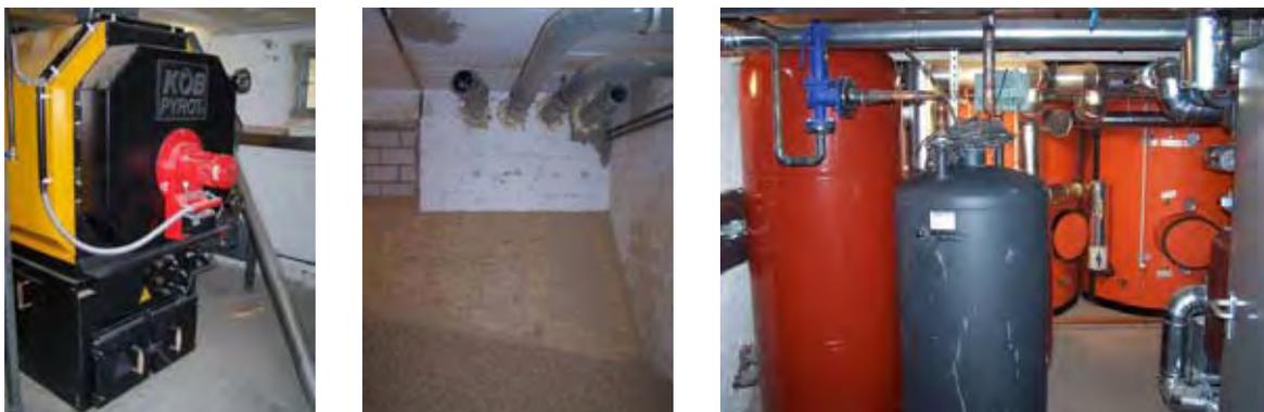
**Bild 250** Holzpelletkessel, Pelletlager, Einbausituation Pufferspeicher, Ausdehnungsgefäß und Nachspeisebehälter
