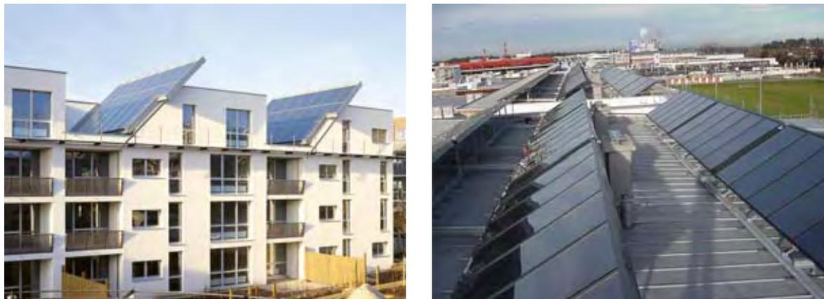
**Bild 245** Beispiele für Kollektorfelder mit guter Zugänglichkeit für Wartungs- und Instandsetzungsarbeiten
