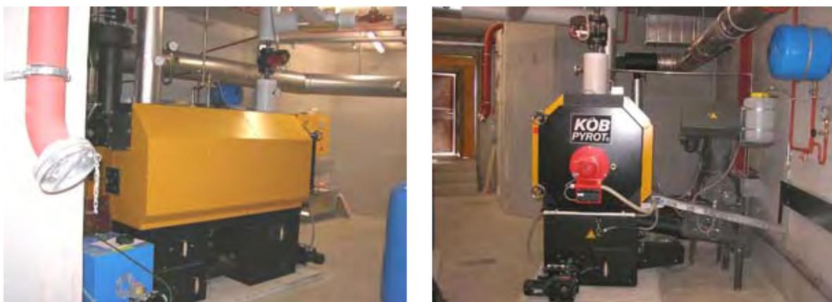
**Bild 237** Einbausituation Holzpelletkessel in der Heizzentrale
