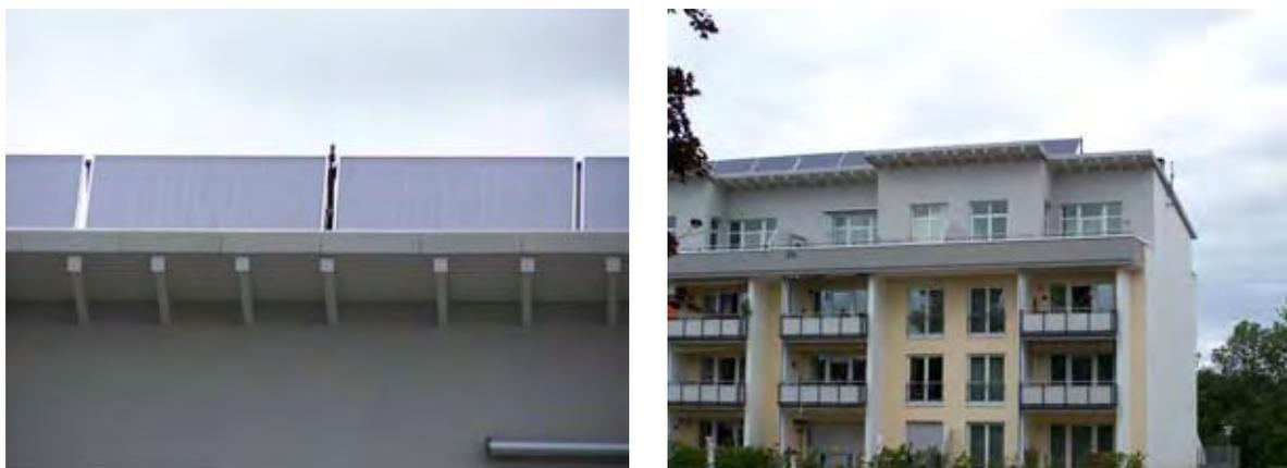
**Bild 262** Kollektoranlage auf dem nach Norden geneigten Pultdach Brentanostraße 54-56
