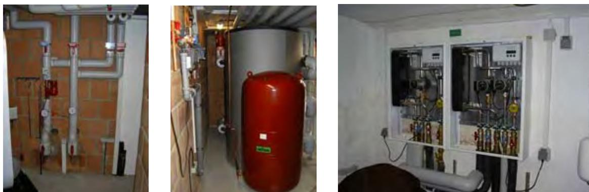
**Bild 258** Nahwärmenetzaustritt Heizzentrale, Ausdehnungsgefäß Nahwärmenetz, Frischwasserstationen
