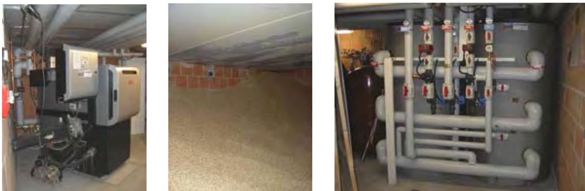
**Bild 257** Holzpelletkessel, Pelletlager, Einbausituation Pufferspeicher 1 und 2
